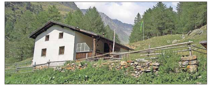
Die Egghof-Kaser wird abgebrochen und neu errichtet. SJR
