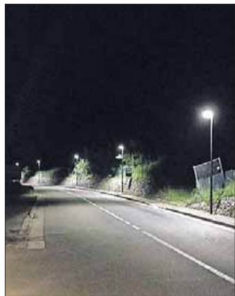
Die neue LED-Beleuchtung in St. Pankraz bei Nacht. Gemeinde
