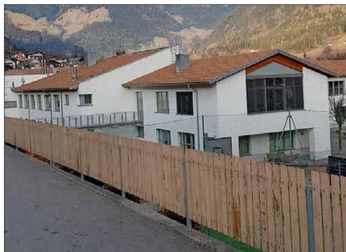
Auch oberhalb der Mittelschule in St. Martin wurde der Zaun erneuert.
