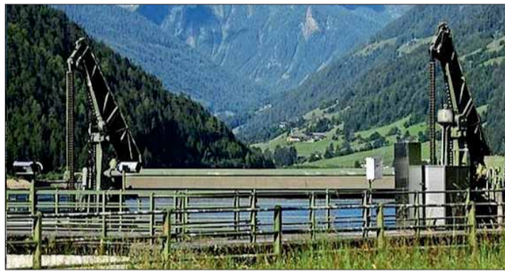
Das Wasserkraftwerk St. Walburg-Kuppelwies.
